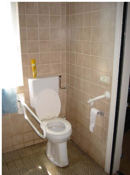
Aangepast toilet in de uitbouw.
