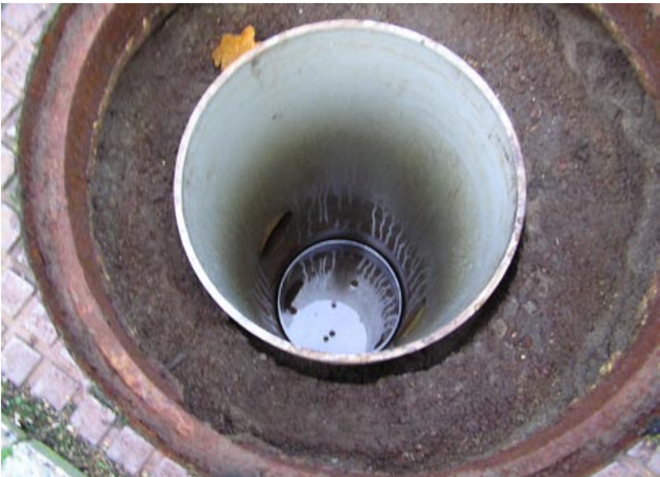
Inspectieput drainagesysteem.
